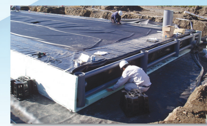
▲施工中の中規模地下貯水槽：貯水量95トン
