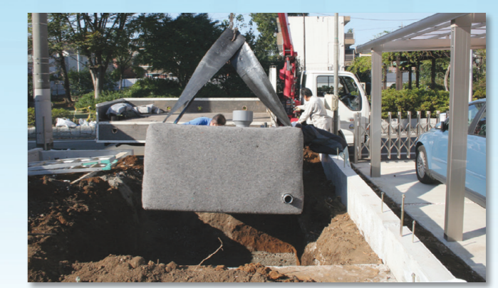
▲小規模なものは工場で作立てて現場に搬入し、クレーンで吊り降ろす
