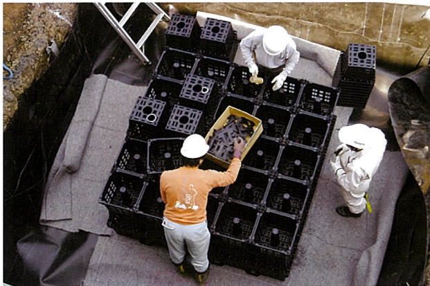
現場での貯留材の組み立て作業
