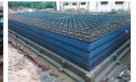
3 内側型枠プラダンの取付
