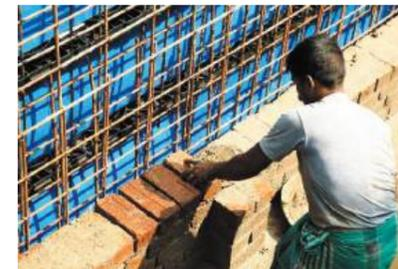
4 レンガ (外型枠) 積み施工
